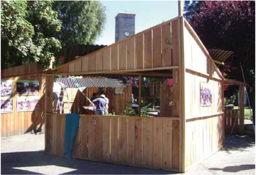
Foto: Construyendo el stand el 4 de febrero (foto del autor).
